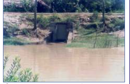
চিত্র: জোয়ারের সময় ফ্লাশ গেটের মাধ্যমে সেচ প্রদান
